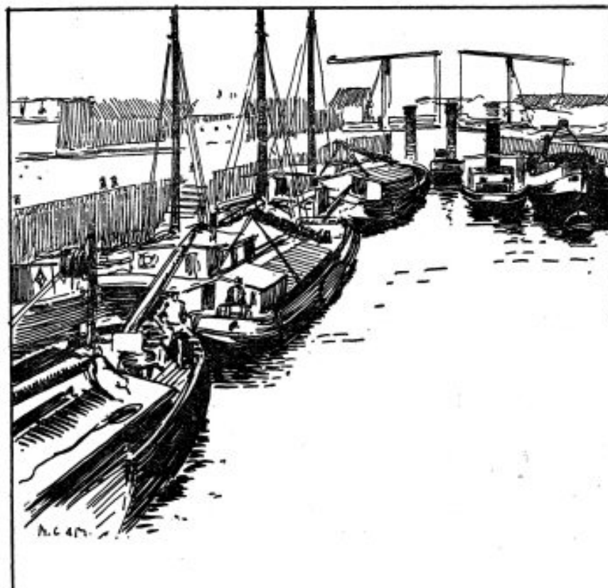
In de sluizen te Vreeswijk.
